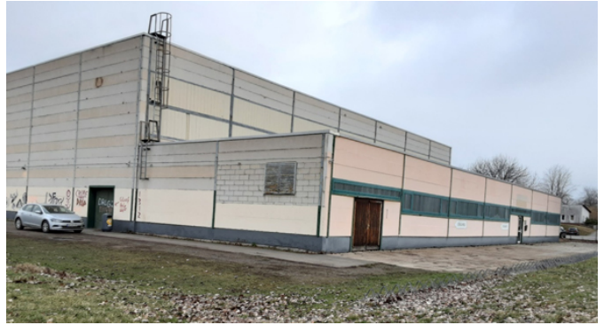
Grundstück, bebaut mit 3-Felder- Sporthalle Damaschkestraße 99974 Mühlhausen Zum Exposé...
